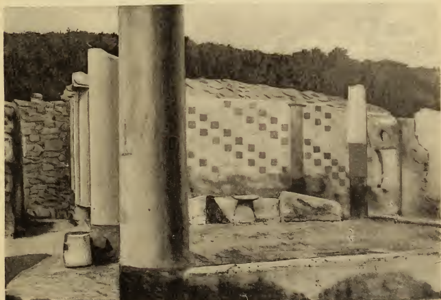
IL TRICLINIO ESTIVO DI TREBIO VALENTE DINING-ROOM IN THE PERISTYLE OF THE TREBIO VALENTE'S HOUSE
