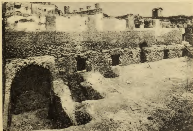
LA TERRAZZA E L'ESTERNO DEL CRIPTOPORTICO THE LARGE TERRACE UPON OF THE CRIPTO-PORCH
